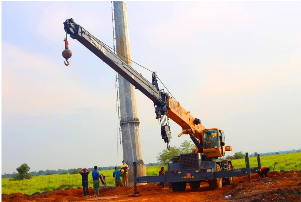
گزارش تصویری از عملیات مربوط به بتن ریزی
